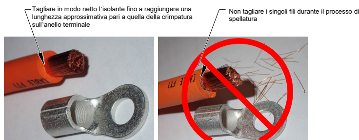
Figura 3.5— Preparazione dei cavi del modulo
